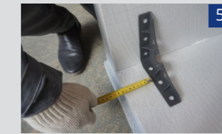
Виконати розмітку місць для установки куточків. Відступ від краю 50-100 см. Відстань між куточками 300-400 мм.
