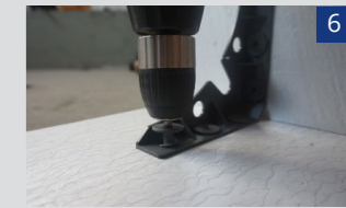
Закріпити кутове кріплення.
