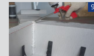
Зазори між плитами заповнити КЛЕЙ-піною для пінополістиролу.
