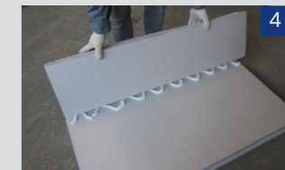
Нанести КЛЕЙ-ПІНУ для пінополістиролу на плити теплоізоляції, встановити торцеву плиту. Для надійного кріплення необхідно з'єднати плити одна з одною через 5-7 хвилин після нанесення клею.
