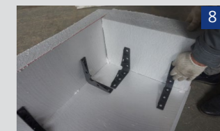
Зафіксувати плити теплоізоляції кутовим кріпленням.
