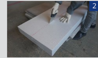
Провести підготовку торцевих елементів незнімної опалубки фундаменту, підрізавши плити в розмір.
