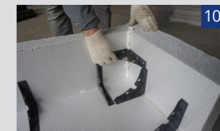
З'єднати торцеві плити теплоізоляції одна з одною за допомогою кутового кріплення.
